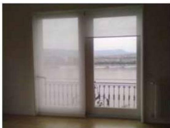
Tokozatba épített roló
